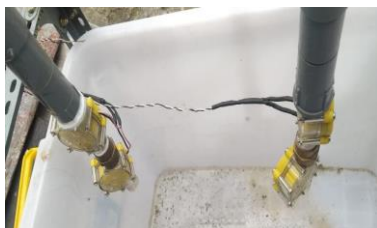
Gambar 9: Instalasi Turbin dan Generator
