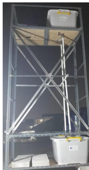
Gambar 5: Instalasi Kerangka Alat
